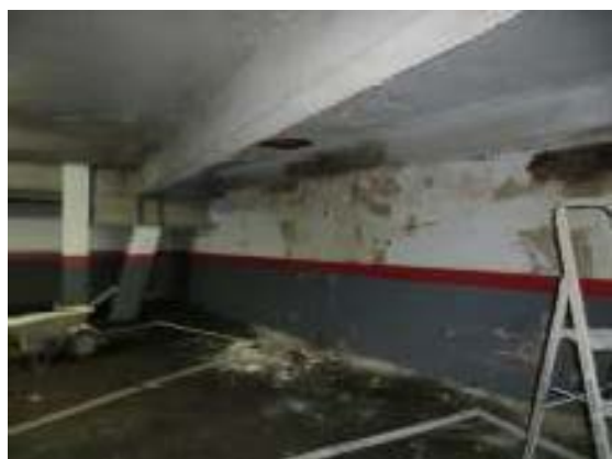
Fotos. Antes y después de la aplicación del sistema Mulmico para el tratamiento de un muro en un garaje subterráneo en Paseo de Recoletos (Madrid).
