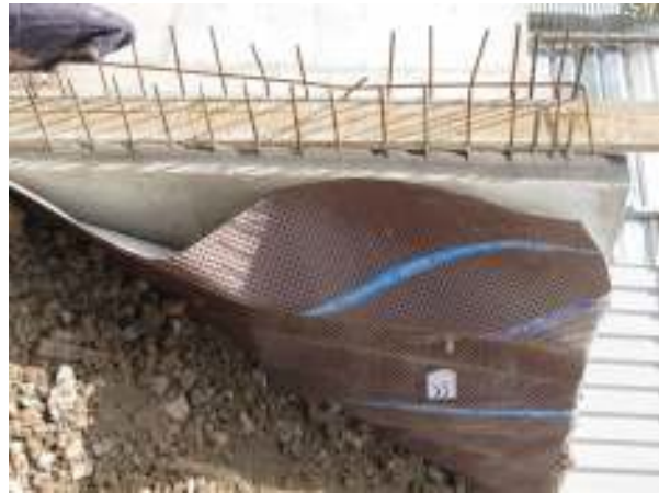
Fotos:-Colocación de láminas trasdosadas durante el proceso constructivo (fotos superiores). Tratamiento en intradós bajo presión negativa y filtración (fotos inferiores)
