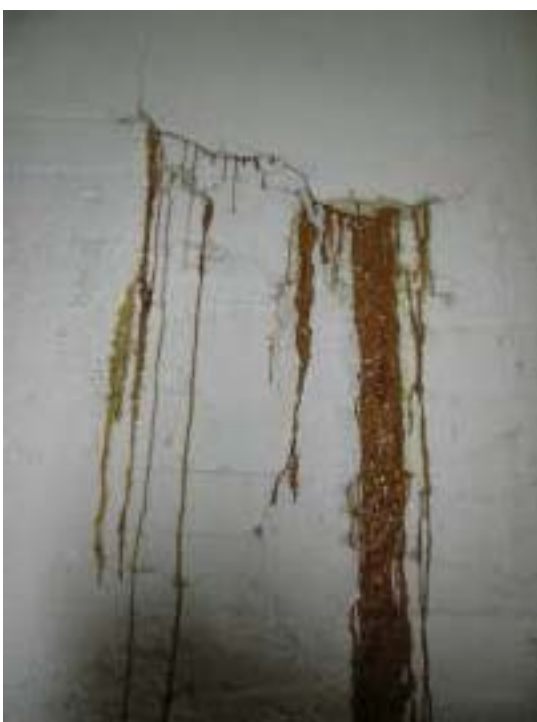
Foto --Tratamiento mediante resinas inyectadas en el trasdós
