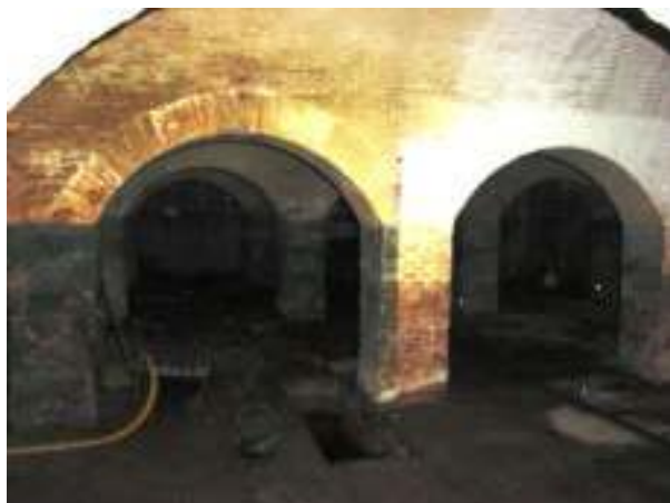
Fotos. Antes y después de la aplicación del sistema Mulmico para la rehabilitación de un sótano inundado en una edificación propiedad de RENFE en Atocha (Madrid).
