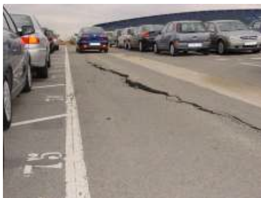
Fotos. Antes y después de la aplicación del sistema Mulmico para el tratamiento y consolidación de suelo en una campa de estacionamiento de vehículos en San Fernando de Henares (Madrid).
