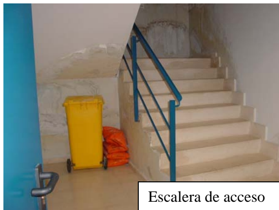
Area interior edificio
